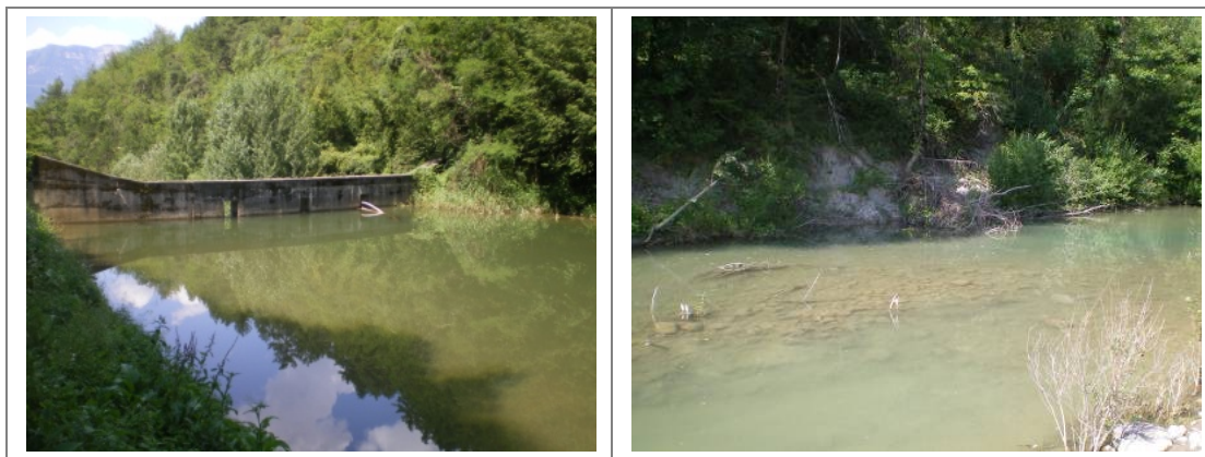
Figura 12.7 – Esempio di opera trasversale (a sinistra) che potrebbe determinare le condizioni di cui al caso 5 previsto in Tabella 12.1 . Il corpo idrico a monte di briglie di trattenuta non colmate o di traverse fluviali, o comunque contenente almeno una di queste strutture, viene considerato potenzialmente HMWB se l'estensione del tratto reso artificialmente lentico dalle opere stesse (a destra) è dominante rispetto alla lunghezza del corpo idrico (> 50%).
